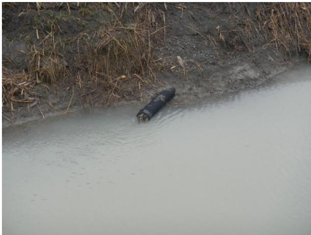
Figure 27 : Exemple de drain non protégé et colmaté
