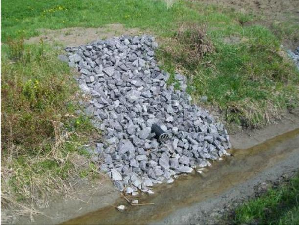
Figure 28 : Sortie de drain protégée (Source : COGENOR)
