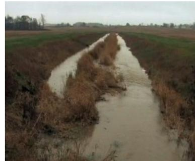
Figure 38 : Principe du chenal à deux niveaux
