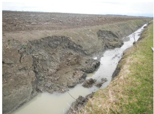
Figure 22 : Rive opposée du ruisseau Vertefeuille montrant également une érosion importante
