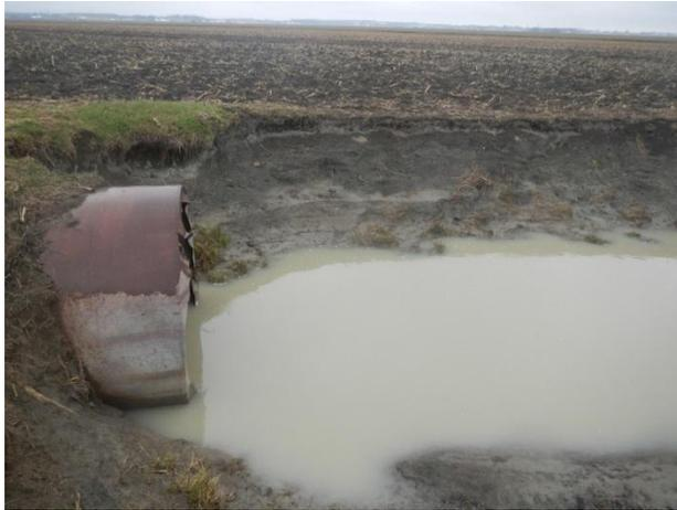
Figure 29 : Élargissement du cours d'eau en sortie de ponceau
