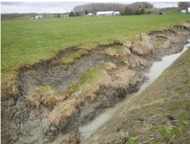
Figure 21 : Effondrement de berge au ruisseau Vertefeuille après un « nettoyage » conventionnel
